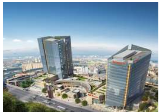
송도 4공구 형지글로벌 패션복합센터 계약년월 : 2020.05 발주처 : 롯데건설㈜
